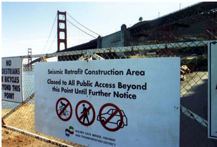
Bild 16 Erdbebensanierungsmaßnahmen an der Golden-Gate-Bridge
