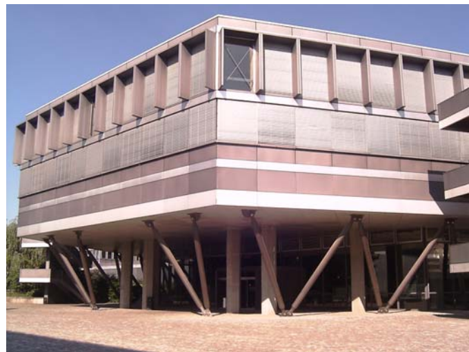
Bild 15 Erdbebensanierungsmaßnahmen an einem Hörsaalgebäude der ETH Zürich
