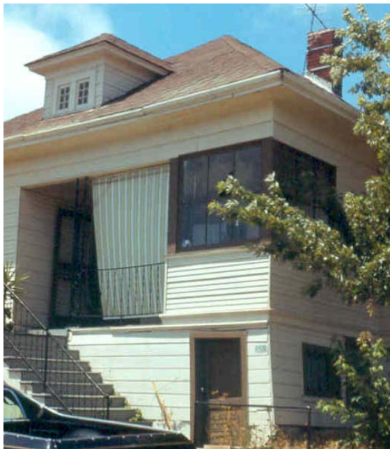
Bild 2: Einfamilienhaus auf der Hayward-Verwerfung in Kalifornien
